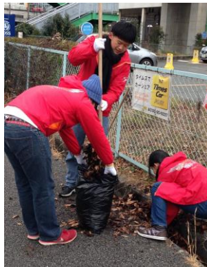
ゴミ袋が枯葉で一杯となった側溝清掃 (日生中央)
